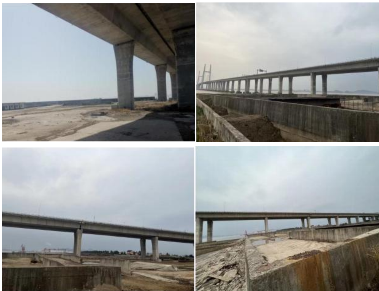
图3 开挖区域现状图
