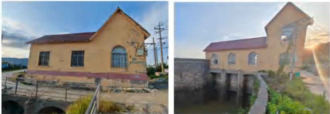
图 2.2-3 老宫闸、断岙闸现状
